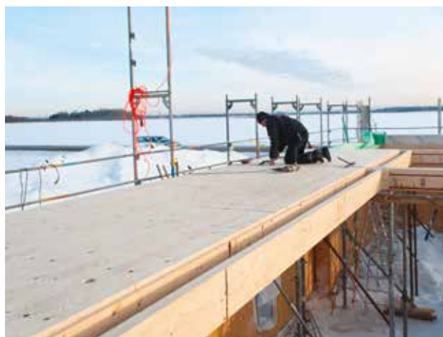
Utilisation de STEICO LVL X pour renforcer la dalle de plancher.
